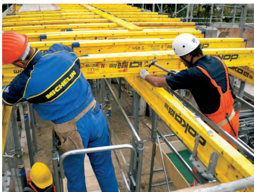
Figura 47 - Fase di montaggio dell'orditura secondaria dal basso con l'uso di ponti su ruote
