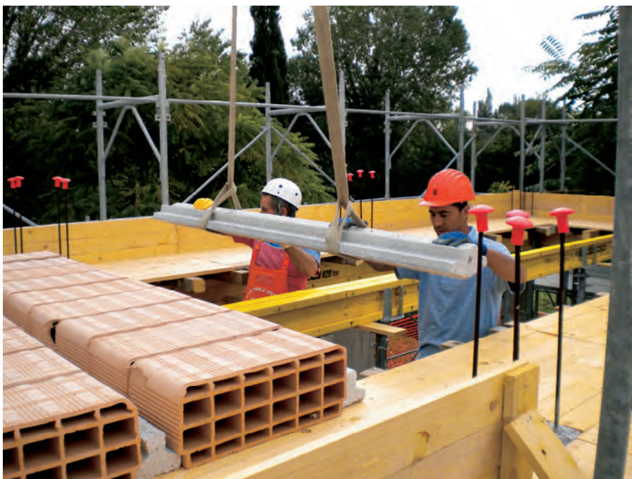
Figura 17 – Fase di posa in opera dei travetti
