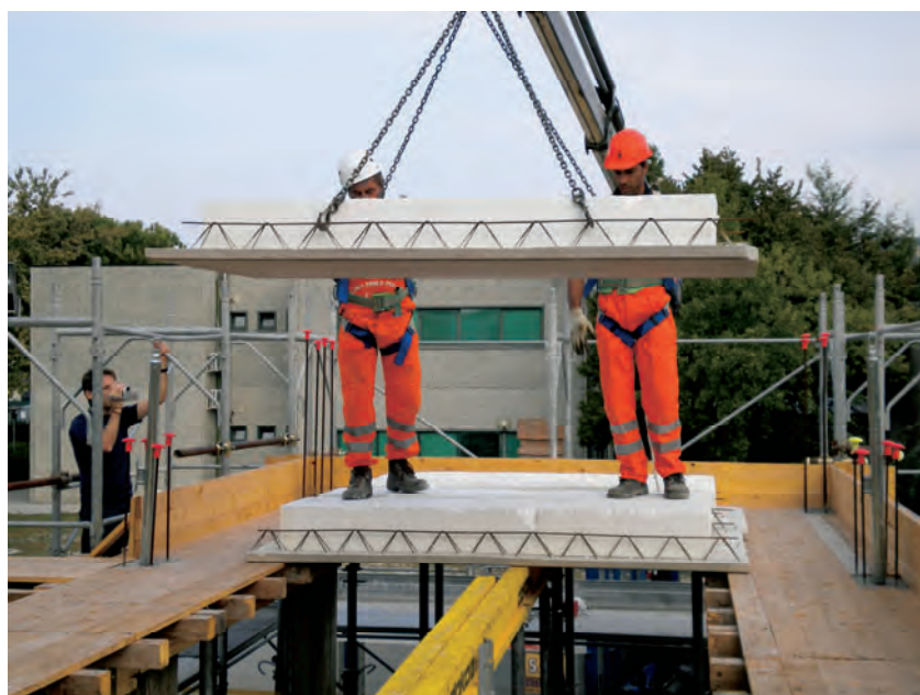
Figura 43 – Fase della posa delle lastre
