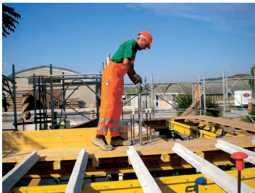
Figura 32 – Inserimento di un'asta nella boccola
