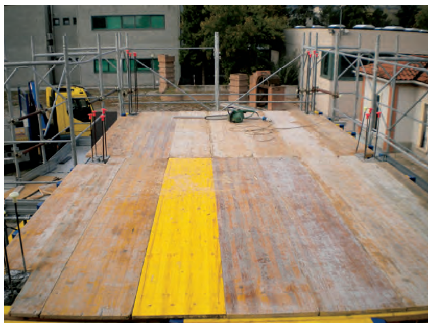
Figura 49 – Banchinaggio ultimato
