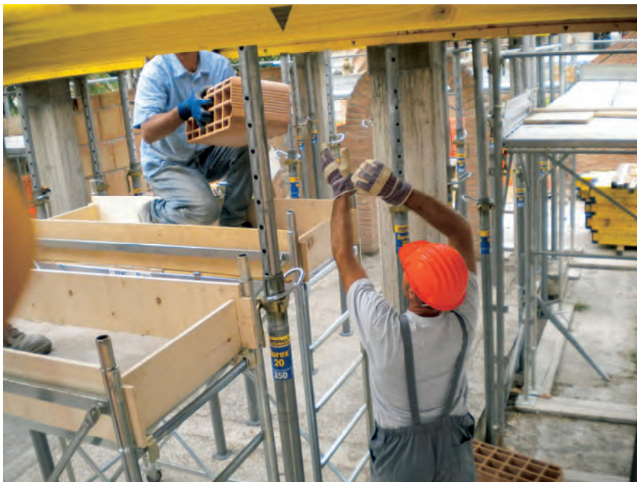
Figura 19 – Fase del passaggio delle pignatte dal basso
