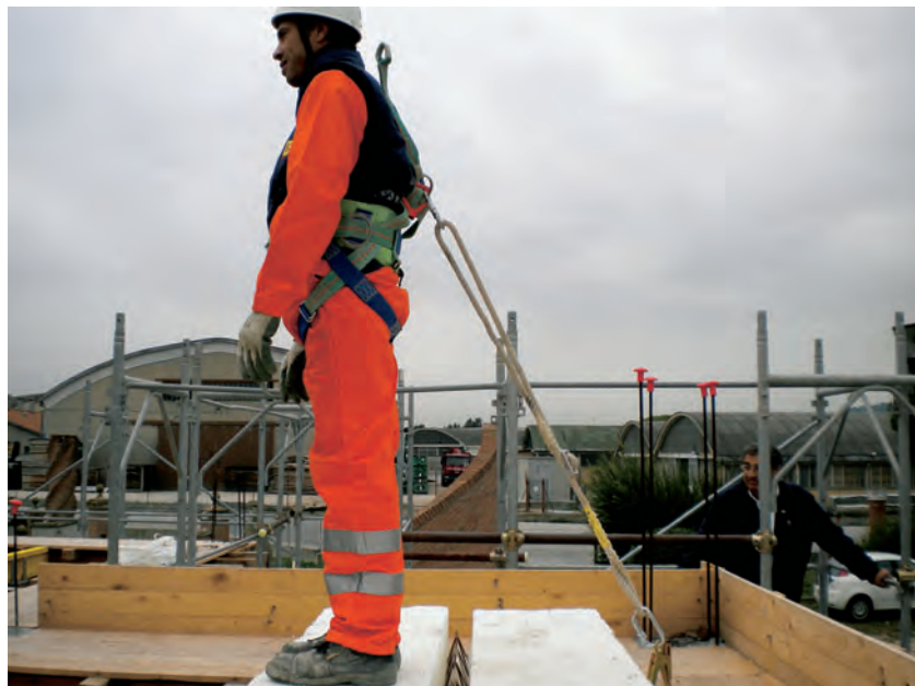
Figura 42 – Operaio nella fase di posa delle lastre successive al primo con cordino di posizionamento agganciato direttamente al pannello
