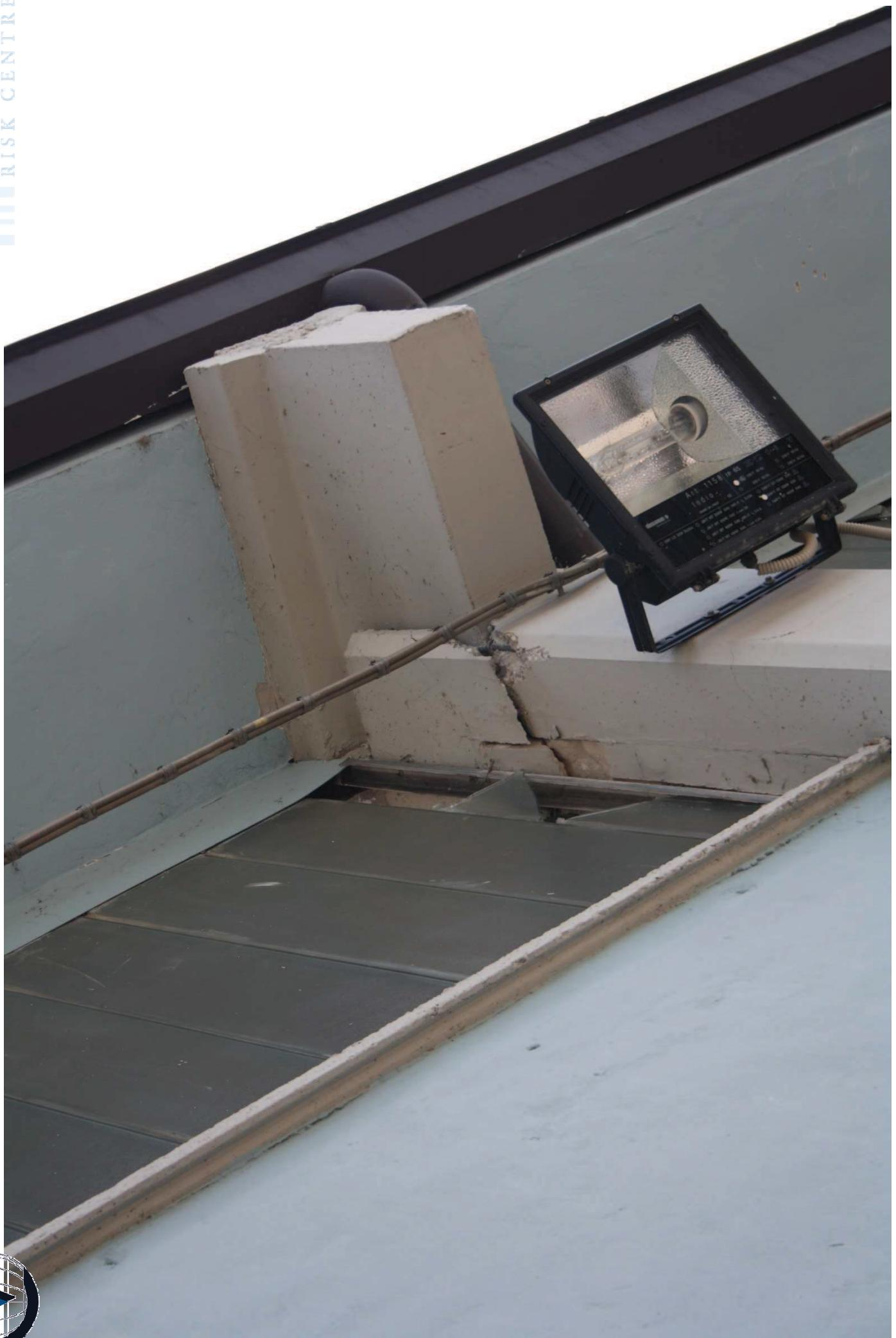
Perdita di appoggio della trave principale in un edificio monopiano prefabbricato con trave principale trasversale
