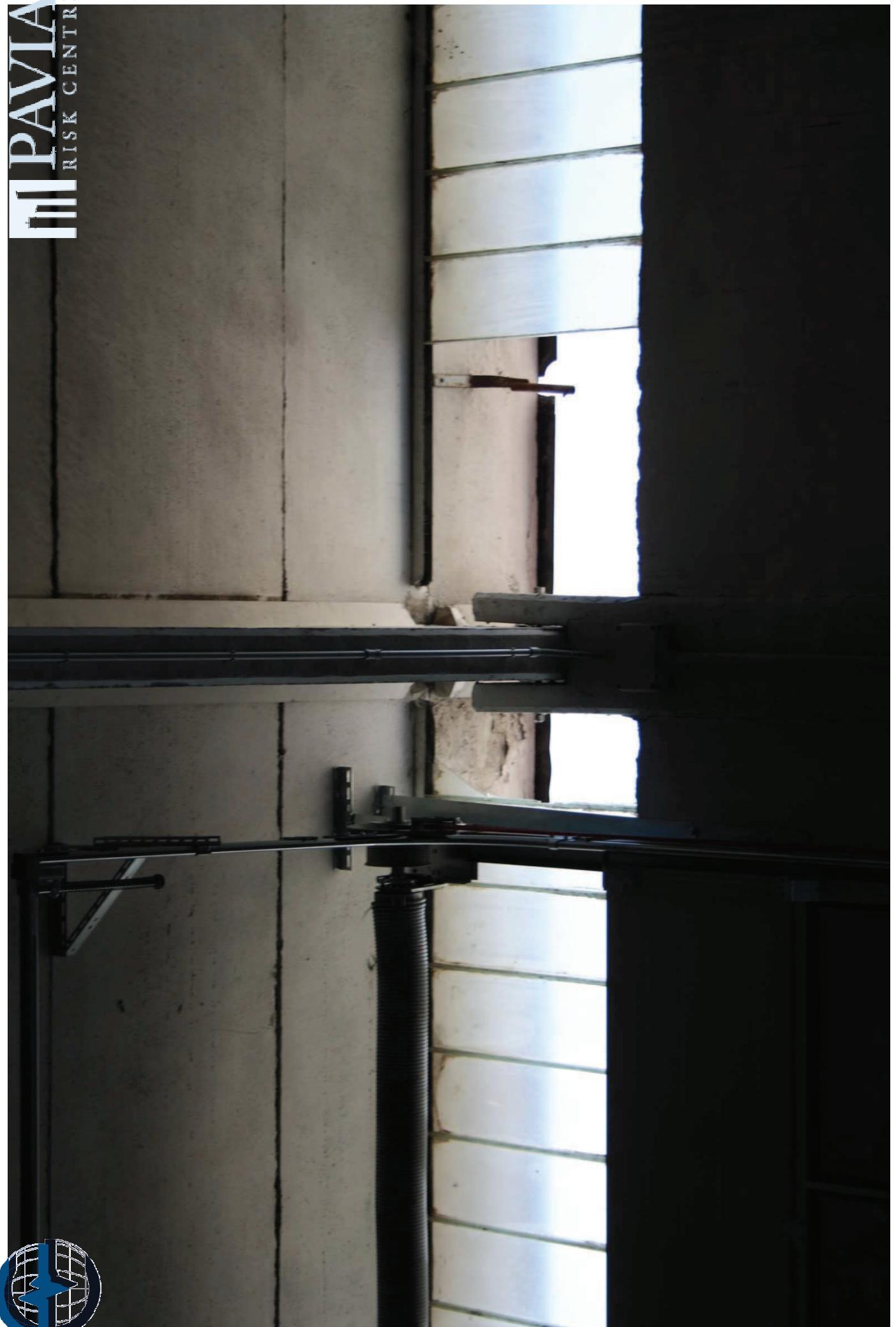
Crisi della forcella in testa ai pilastri per martellamento della trave in un edificio monopiano prefabbricato con trave principale trasversale
